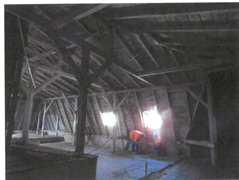
PLANȘA NR. 24 Relevu actual al planului podului și mansardei. Fotografii actuale din pod. Structura de lemn a șarpantei pe scaune.
